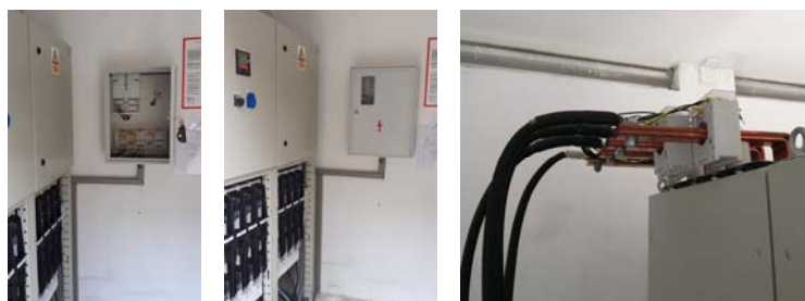
Slika 2 - Montaža razvodnog ormara u armiranobetonske transformatorske stanice i strujnih mjernih transformatora na ulaznim sabirnicama u niskonaponski blok
