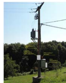
Slika 3 - Dodatni razvodni ormar za montažu strujnih mjernih transformatora na stupne transformatorske stanice
